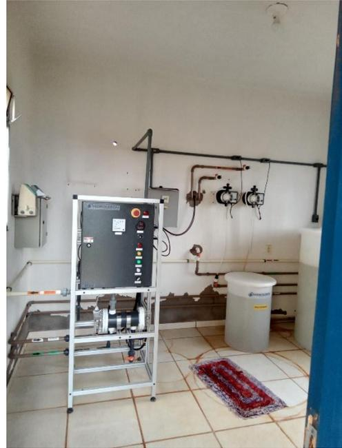
Foto 58 – Dosadoras e tanques de diluição
