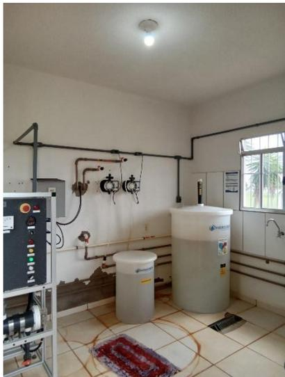
Foto 59 – Dosadoras e tanques de diluição
